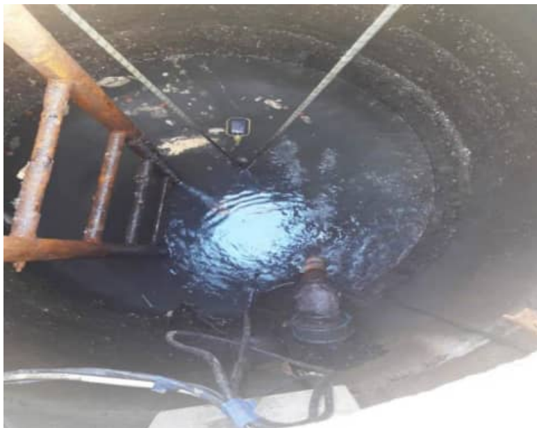
Рис. 9.2.6. Колодец с насосом на мини КНС.
