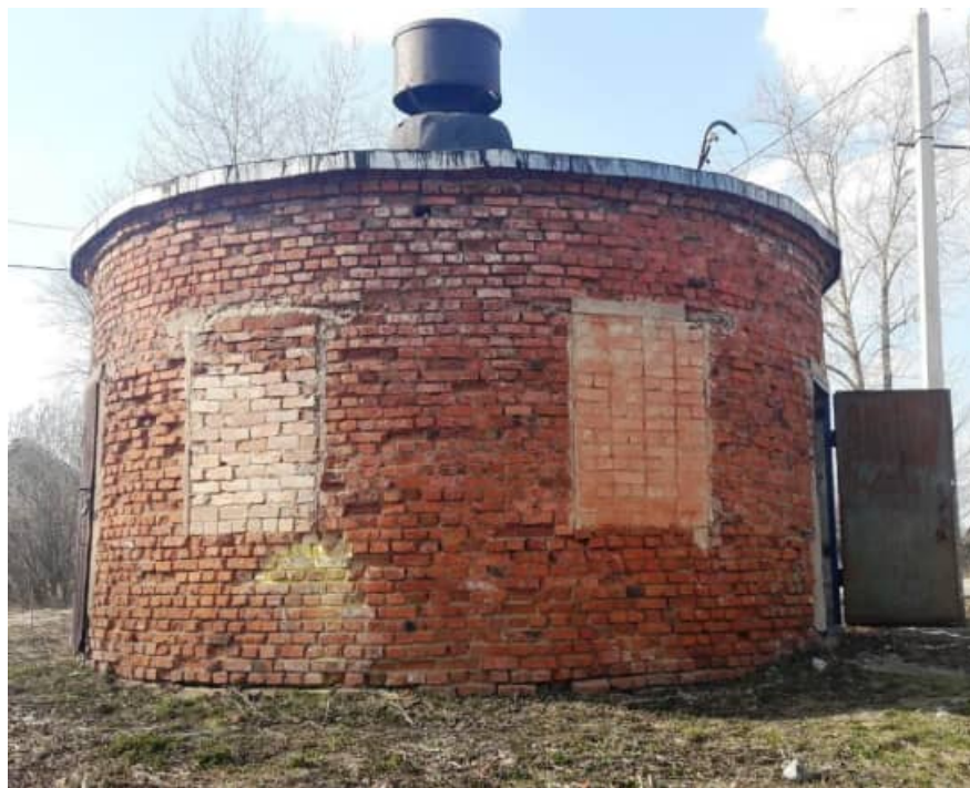
Рис. 9.2.5. Здание КНС Лесная.
